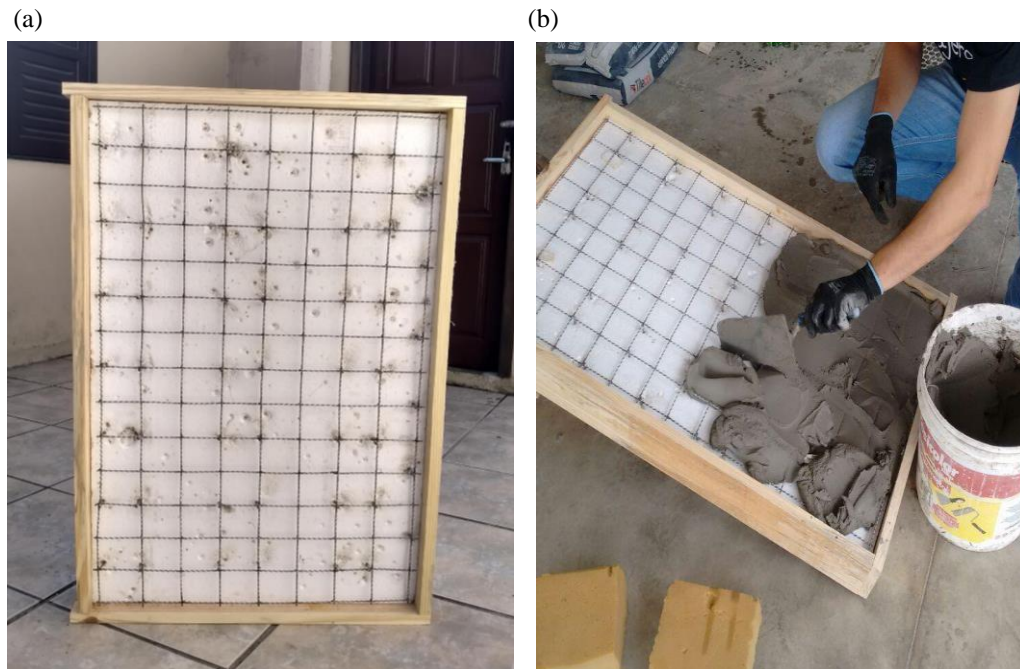
Figura 3. Montagem das pequenas paredes: (a) placa de EPS tela electrossoldada, (b) aplicação da argamassa sobre placa
