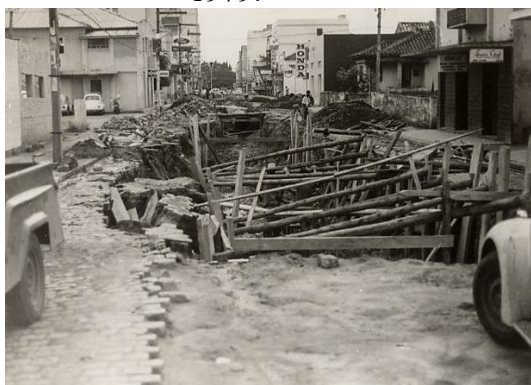
Imagem 1 – Construção de canais auxiliares para conter as cheias do rio na rua Marcos Rovaris em 1979.
