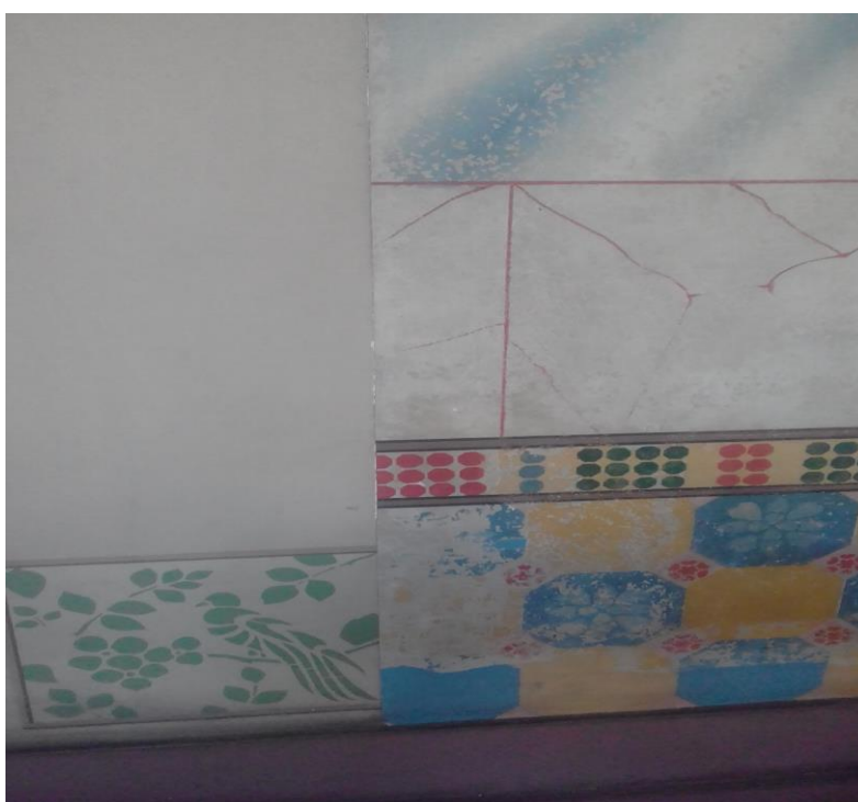
Figura 2: Detalhe da parede no piso térreo marcando os três usos dados ao Solar; do lado direito a cor marrom claro com detalhes em verde são parte da atual pintura do museu, na parte inferior esquerda as formas geométricas datam da segunda reforma da escola em 1906, e na parte superior esquerda está o revestimento de escaiola da época em que o Solar era residência da família Leitão. Fotografia da autora, 2017.
