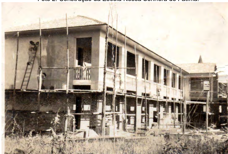
Foto 2: Construção da Escola Nossa Senhora de Fátima.
