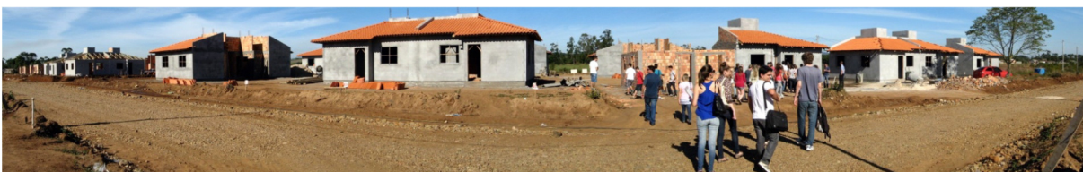
Figura 16. Etapa de finalização da obra das unidades. Fonte: equipe de projeto.
