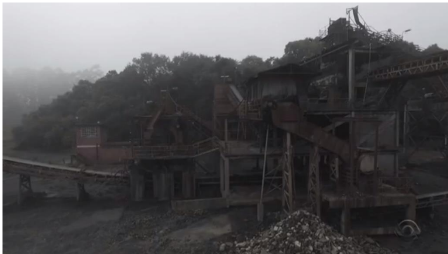
Figura 1 – Instalações de mina de carvão abandonada, Forquilha, SC.
