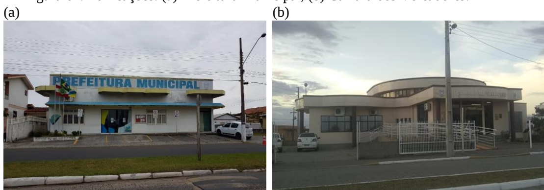
Figura 01. Edificações: (a) Prefeitura Municipal, (b) Câmara dos Vereadores.
